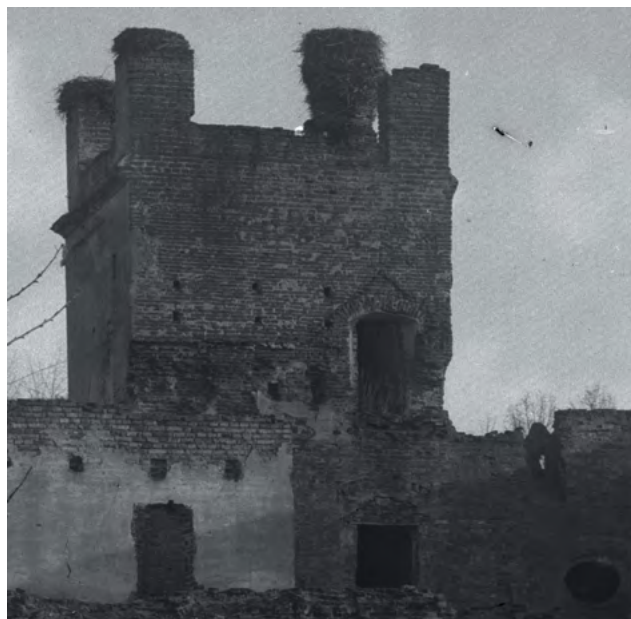
14 Brok, ruina pałacu biskupiego, widok wejścia z klatki schodowej wieży na drugie piętro budowli. Fot. Kazimierz Broniewski, 1909 (fragment), Zbiory Fotografii i Rysunków Pomiarowych IS PAN, nr neg. B1553
