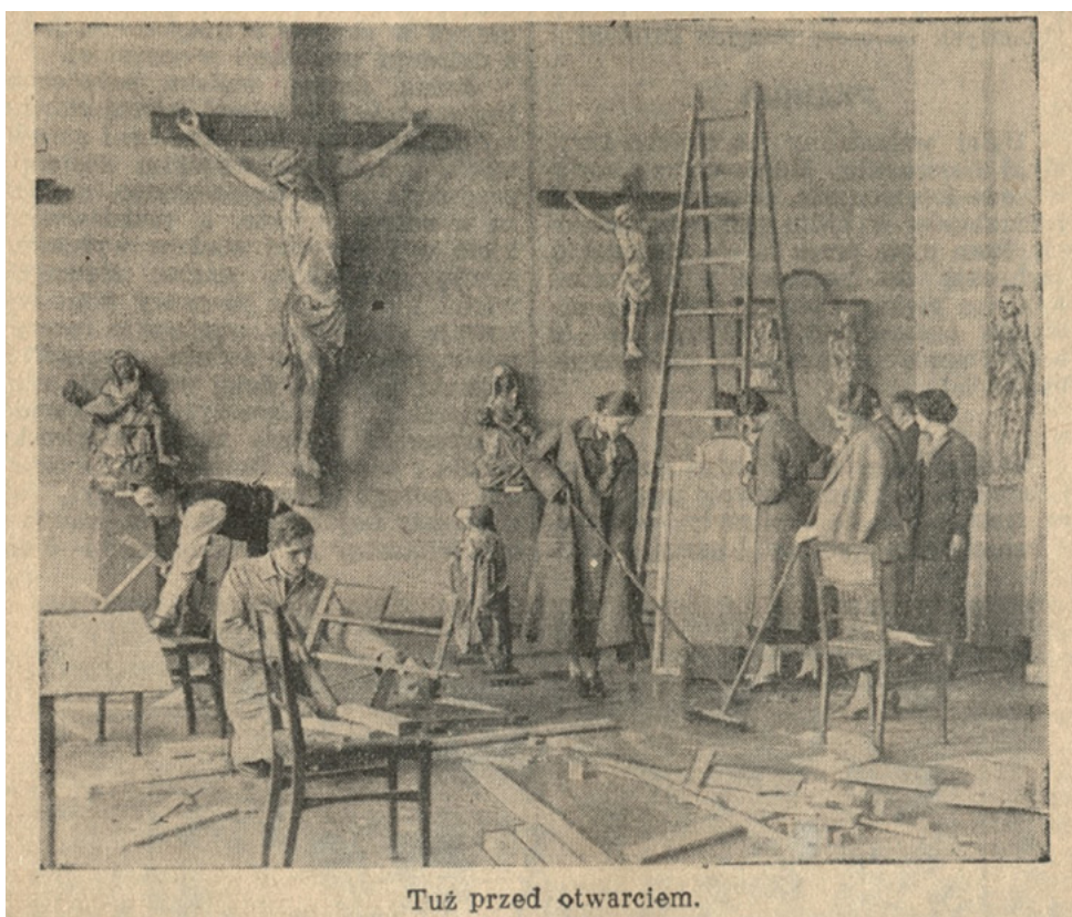
6 Wystawa Wielkopolska plastyka gotycka, studenci przygotowujący ekspozycję na tle ściany północnej sali pierwszej. Fotografia ilustrująca artykuł Wielkopolskie zabytki gotyckie zamieszczony w „Kurierze Poznańskim” (nr 201, 30 IV 1936, s. 4)
